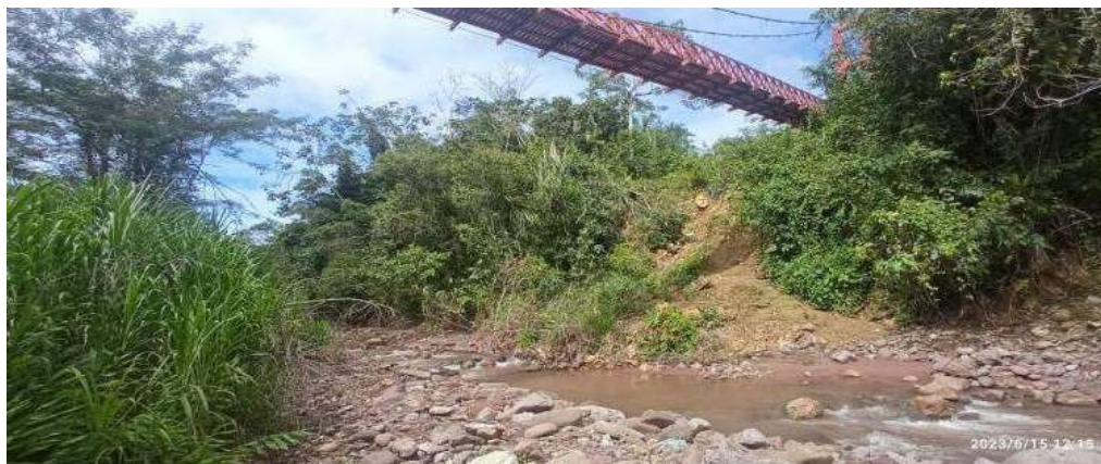
FIGURA N°01: SE OBSERVA LA EROSIÓN DEL SUELO EN LA RIBERA DEL RIO LOCO
